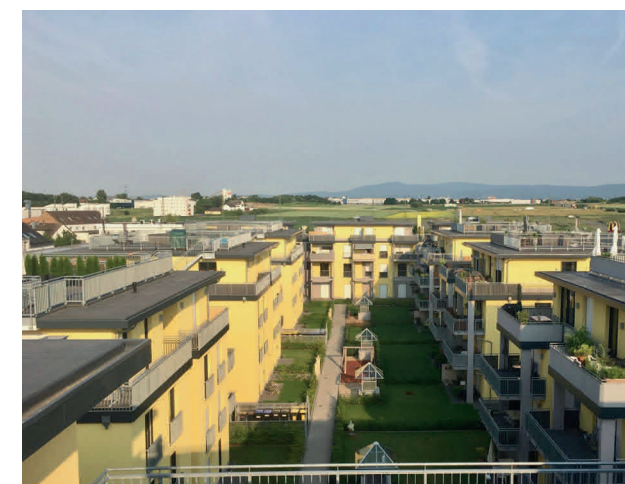
Bad Vilbel, 120 Wohnungen in 12 Gebäuden und Tiefgarage
