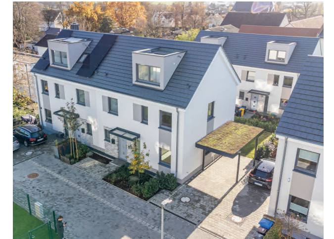
16 Doppelhaushälften und 5 Reihenhäuser
